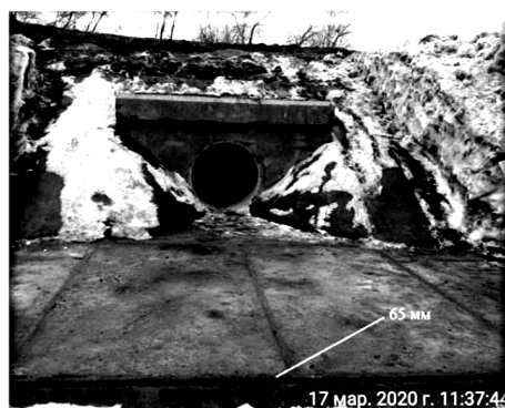
Смещение конструктивных элементов в местах отвода воды на оголовке водопропускной трубы
