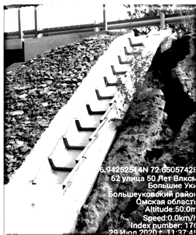
Размытие грунта в основании моста через реку Большой Ук
