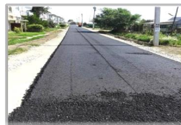
Ремонт автомобильной дороги по ул. Мичурина в р.п. Крутинка.
