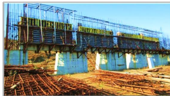
Строительство судоходного шлюза
