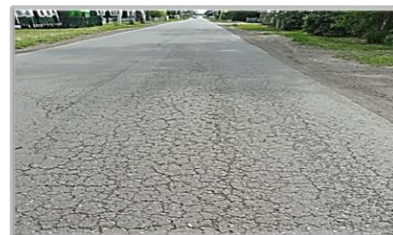
Отремонтированный участок автомобильной дороги в г. Тюкалинске
