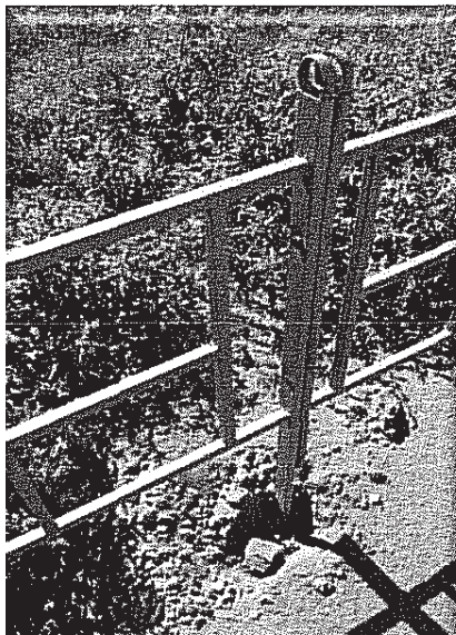
Ограждение по ул. Перелета в г. Омске
