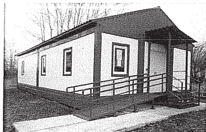
ФАП в с. Кутырлы Колосовского района
