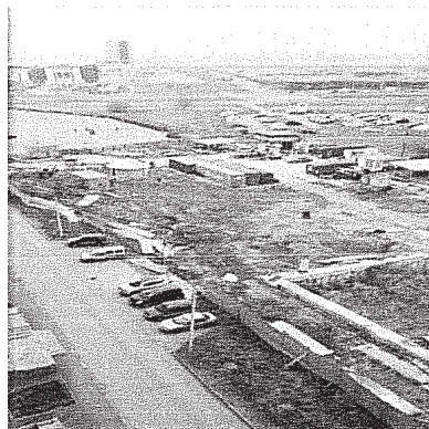
Объект метрополитена (строительная площадка «Вентиляционная камера»)
